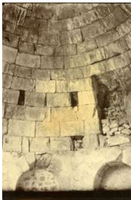
Рис.18. Ф. 169. Оп. 1. Д. 9. Л. 87 с подписью Ф.И. Успенского на обороте: «Дворцовая церковь. Купол нижнего отделения».
